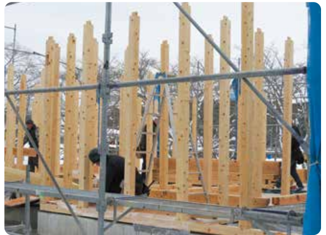
棟上げの状況
