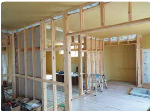
内部の施工状況
