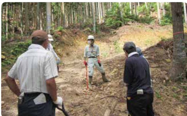
より路面洗掘防止効果を発揮する丸太横断工の設置場所の検討
