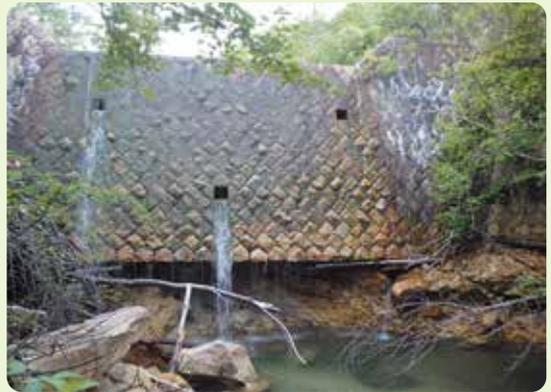
練石積堰堤（底部洗掘状況）
