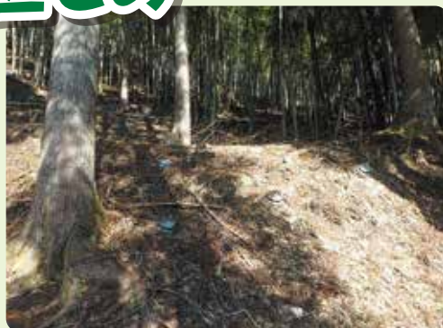
頭部連結補強土工法（ユニットネット工法）による 樹木を残した施工
