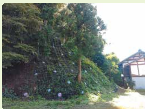
人家裏の斜面の施工
