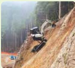
高所法面掘削機による法面整形
